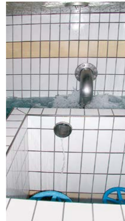
Die Unterbrecherschächte verringern den Druck auf dem Weg vom Schlossberg zum Abnehmer.
