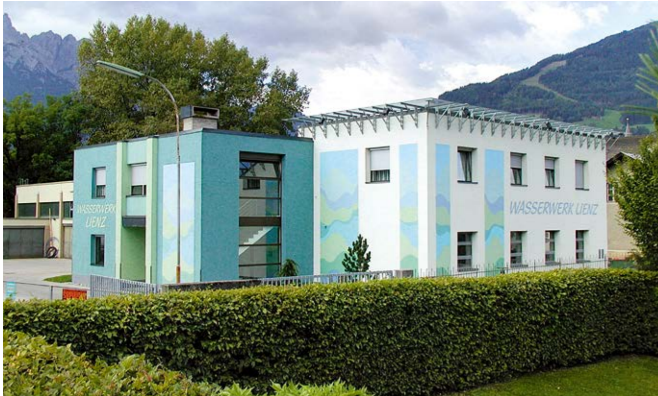
Das Städtische Wasserwerk in der Fanny-Wibmer-Pedit-Straße.
