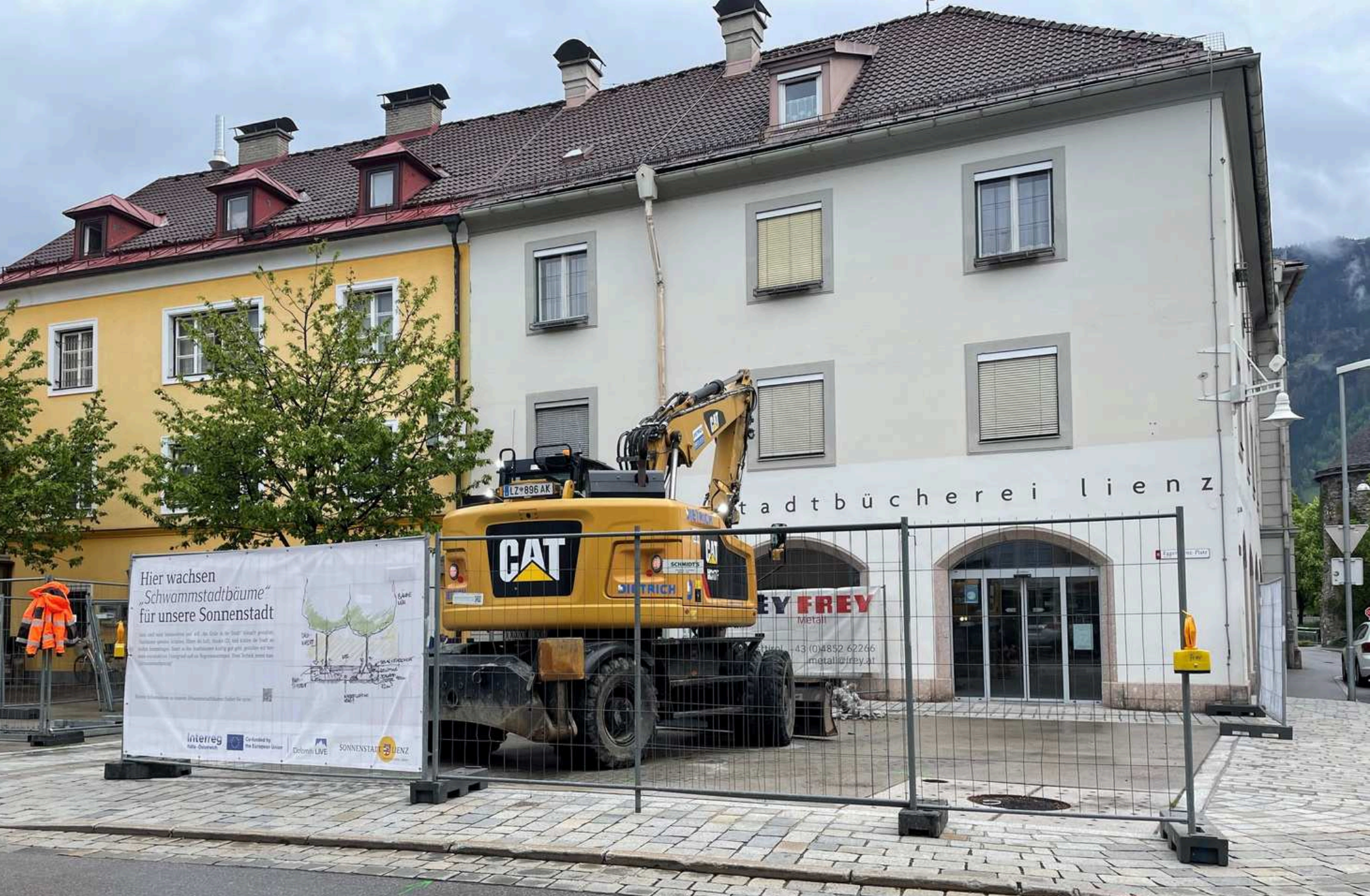
Beginn der Entsiegelung des Egger Lienz-Platzes für die Umsetzung der Schwammstadtmethode für Bäume
