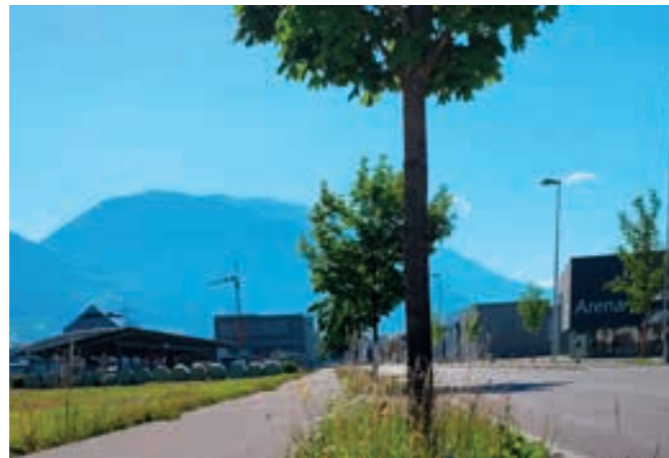
Sickermulde mit Magerwiese und Baumpflanzung in der Franz Kranebitter-Straße – Straßenwässer werden eingeleitet und durch Versickerung gereinigt
