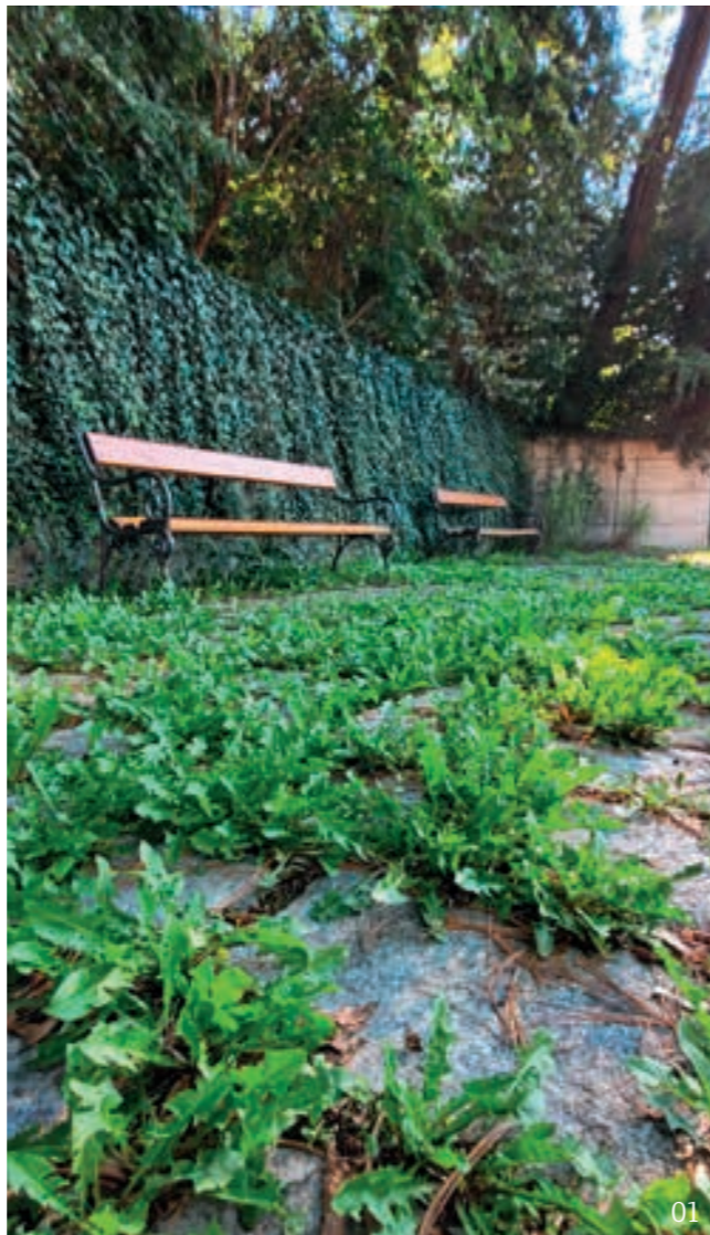
01 Versickerung ist in dieser Pflasterfläche möglich, auch können sich Pflanzen in den Fugen ansiedeln – was in klimatischer Hinsicht als auch aus biodiversitätsfördernden Gründen positiv zu bewerten ist.
