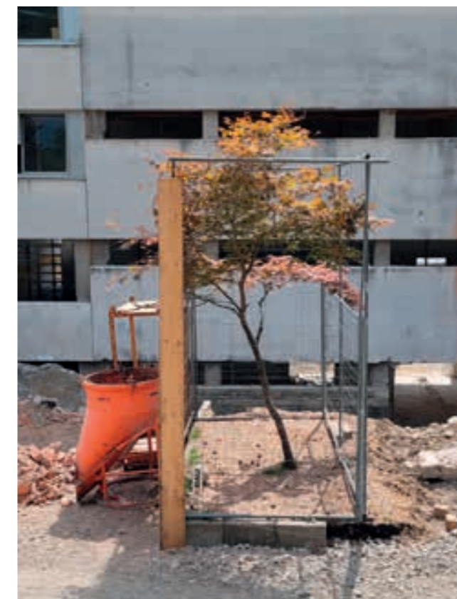
Baumschutz auf der Baustelle Nordschule - die fix montierte Abzäunung soll den kleinen Fächerahorn vor Schädigungen schützen
