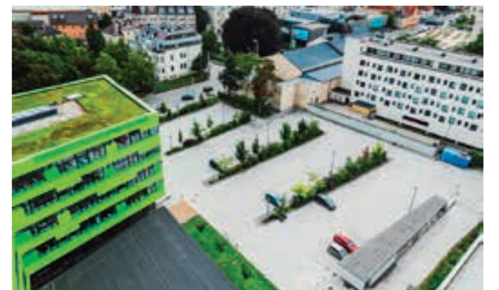
Parkplatz der HTL St. Pölten vor und nach der Umgestaltung ( c) Fa. Zenebio, Draingarten Regenwassermanagemen)
