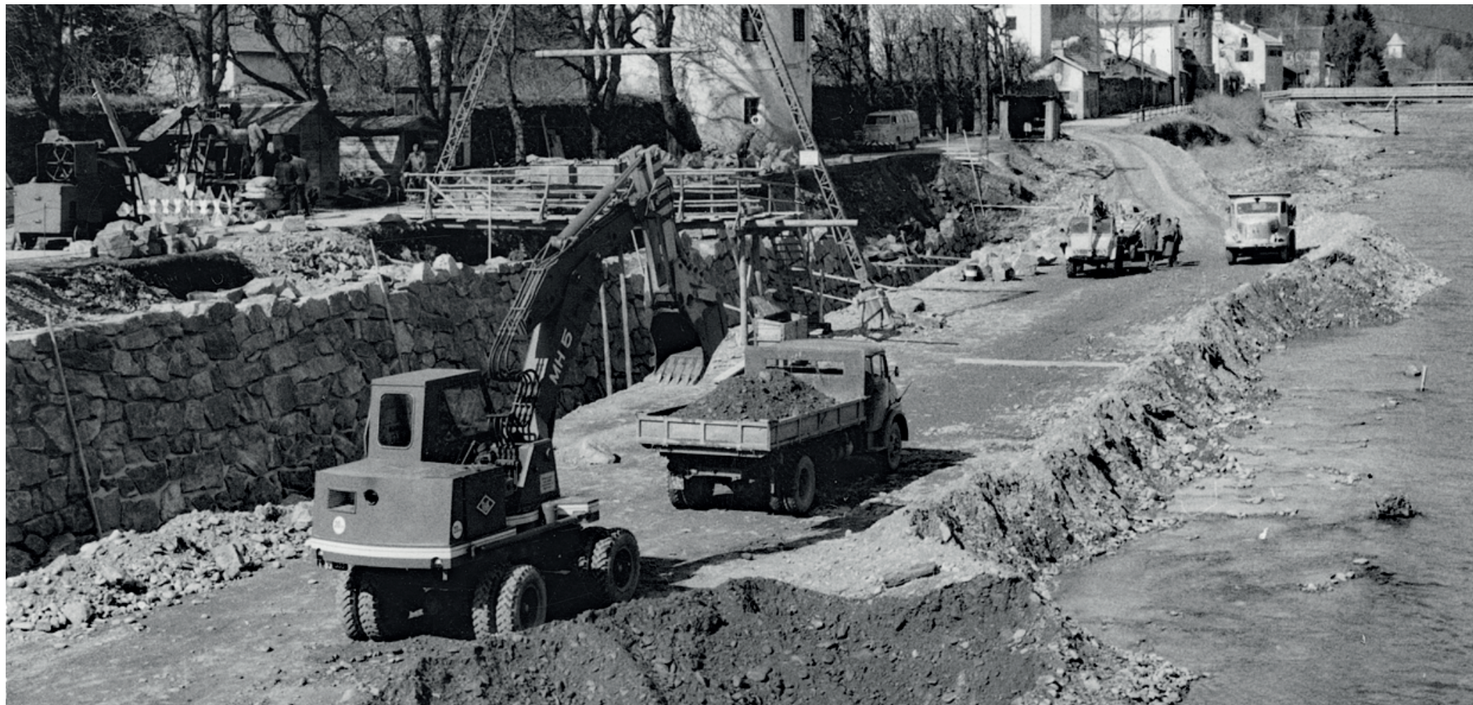
▲ Schutzbauten Iselkaimauer im Flussbett, Frühjahr 1964 (Fotograf: Unbekannt – Archiv Baubezirksamt Lienz)
