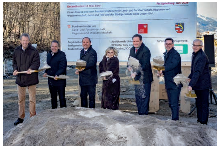
► Feierlicher offizieller Spatenstich für das 14 Millionen Euro-Unterfangen „Hochwasserschutz Isel“ in Lienz, 5. Feber 2024, v.l.n.r.: Walter Frey (ausführende Baufirma), Johannes Nemmert (Leiter Baubezirksamt Lienz), Landeshauptmann-Stellvertreter Josef Geisler, Bürgermeisterin Elisabeth Blanik, Bundesminister für Land- und Forstwirtschaft, Regionen und Wasserwirtschaft Norbert Totschnig, Markus Federspiel (Land Tirol/Abteilung Wasserwirtschaft) und Walter Hopfgartner (Baubezirksamt Lienz).
